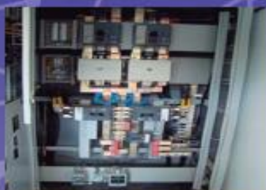
Transferencia Automática, Intermeda
