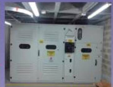
Montaje celda Sm6 Subestaciones 400KVA Merckduración Ltda.
