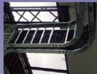
Sistema portacables, Industrias CADI S.A
